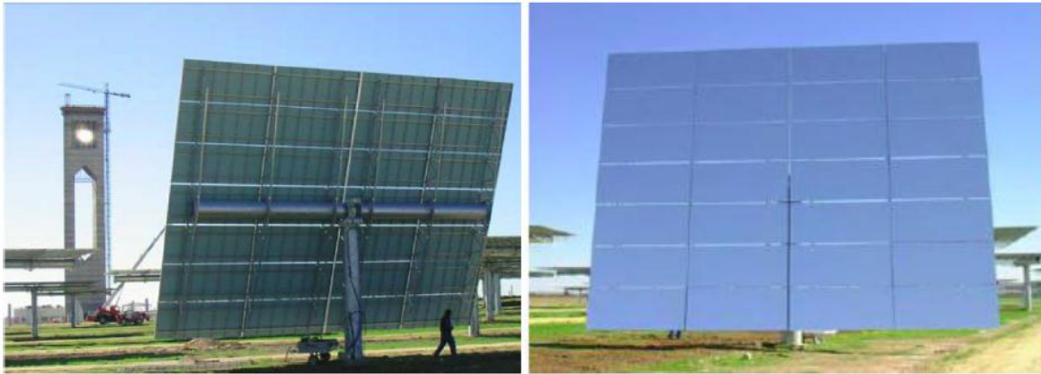
شکل ۲۹ نمای پشت و جلوی هلیوستاتی با ۱۲۱ متر مربع مساحت آینه در نیروگاه PS10 اسپانیا
